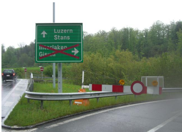
Abb. 6.16 Sperren der Einfahrt.
